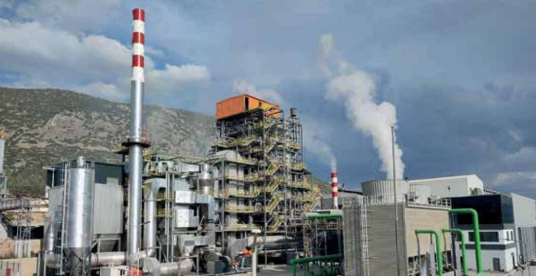
Denizli Biyokütle Elektrik Üretim Santrali
